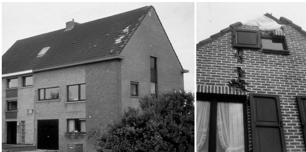
Figure 1 – Exemples de toits et de façades endommagés par la foudre
