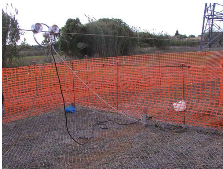
Mise à la terre roulante en utilisation — Earthing roller in use
