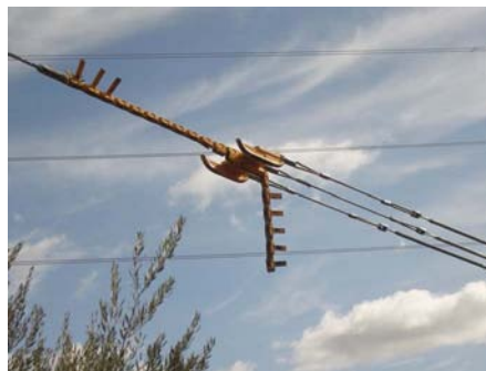
Palonnier de déroulage en utilisation — Running board in use
