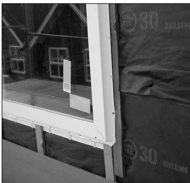
FIG. 8—Sill pan visible.
