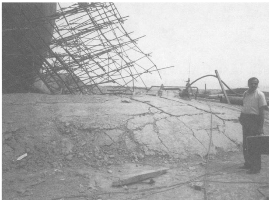
FIG. 17 India LNG spheres - foundation failure.
