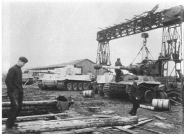
Derartige Montagekräne konnten nur weit im hinteren Operationsgebiet im sogenannten Instandsetzungsdepot aufgebaut werden. Wie erkennbar (siehe Räderachsen) war es ein beweglicher Kran. Auf beiden Fotos wird die Montage eines Turmes gezeigt. Im Hintergrund ein Tiger mit gutem Winteranstrich.
