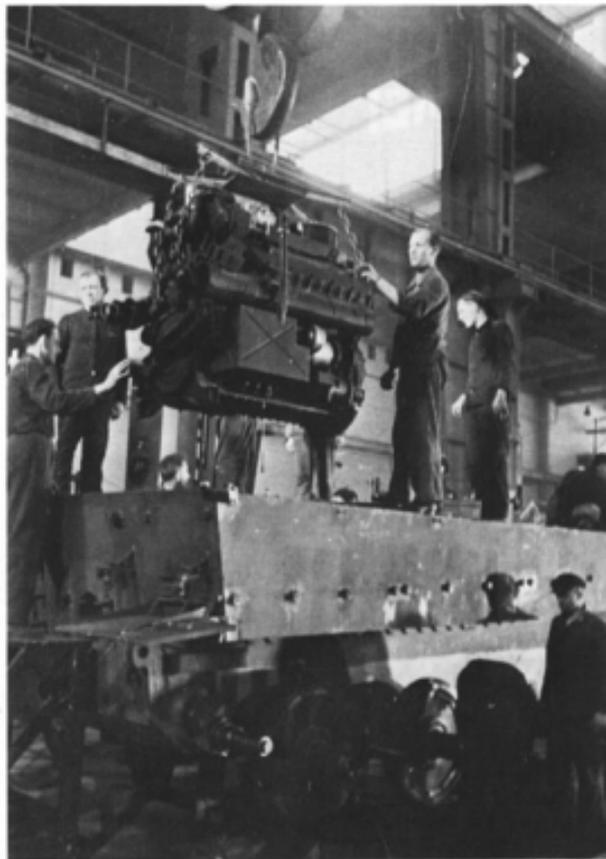
Beide Fotos zeigen die Montage von Motor-Trieb- und Laufwerk. Hierzu stehen die Wannen auf einem Montageband. Bei dem Motor handelt es sich um einen Vergasermotor von der Fa. Maybach (HL 210 P 45) mit 12 Zylindern und einer Leistung von 650 PS. Das Getriebe stammt ebenfalls von Maybach und war ein halbautomatisches Vorwärtsgetriebe mit 8 Vorwärts- und 4 Rückwärtsgängen.
