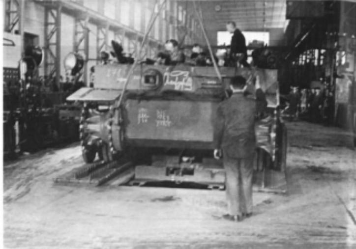
Unten: Dieses Bild läßt die Anordnung der Laufrollen erkennen. Es sind vier Reihen zu je vier Laufrollen, wobei die beiden mittleren Reihen aus Doppellaufrollen bestehen. Insgesamt steht also der Tiger auf 8 Achsen mit 24 Laufrollen. Dieses Foto läßt auch die große Breite der Ketten (Gefechtskette: 725 mm, Verladekette (Foto): 520 mm erkennen.
