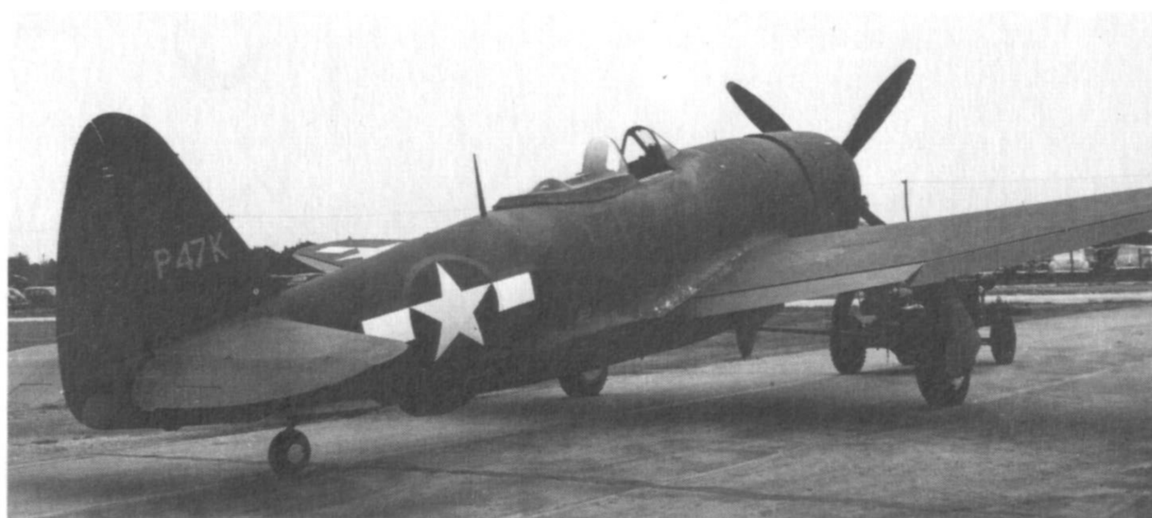
Die XP-47 K wurde gebaut, um das Kabinendach aus geblasenem Glas zu testen. Die Versuche waren so erfolgreich, daß dieses Dach zur Standardausrüstung wurde.
