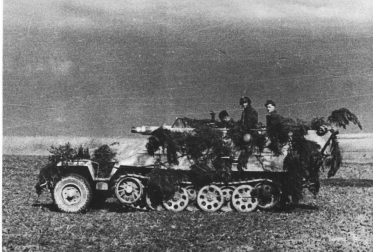
Nachdem die Kampfpanzer IV und Sturmgeschütze III längere Kanonen erhielten, wurden die übriggebliebenen Kwk und Stuk in Schützenpanzerwagen eingebaut (2 x BA).
