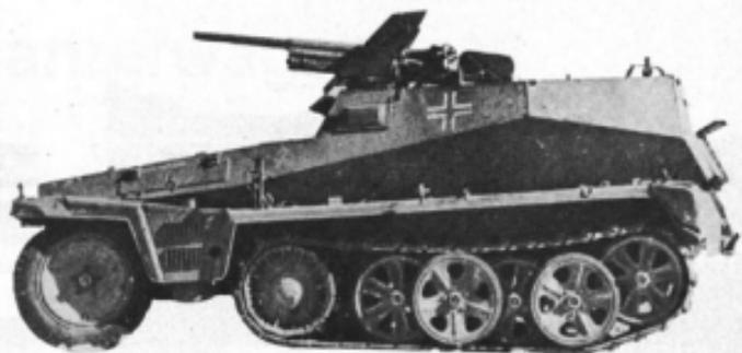
Die beiden oberen Bilder zeigen den leichten Kanonen-Schützenpanzerwagen Sd. Kfz. 250/10 mit der 3,7-cm-Pak 36, links mit dem späteren kleinen, nur linksseitigen Schild, um eine bessere Gefechtsfeldbeobachtung zu gewährleisten.
