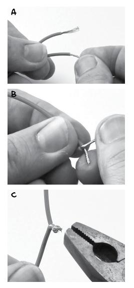
FIGURE B-2: JOINING WIRES BY TWISTING
