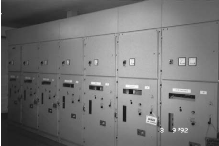
Fig. 2.1 11kV switchboard, Jersey ( Siemens plc ).
